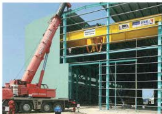
▲ Ein interkontinentales Projekt: In dem neuen Werk von General Electric in Ghana wird die Krananlage von Stahl Cranes & Hoist aus Südafrika mit der Technik von Stahl Cranesystems aus Künzelsau aufgebaut (Foto: Stahl Cranesystems)
