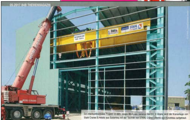
Ein internationalisiertes Projekt in dem neuen Werk von General Electric in Ghana wird die Krananlage von Stahl Cranes & Hoists aus Südafrika mit der Technik von STAHL CraneSystems aus Künzelsau aufgebaut.
