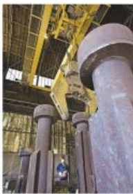
Der neue Kran im modernen Teil der Halle kann mit seinem Geometrie die großen Stahlkörper sicher und schnell aufnehmen.
