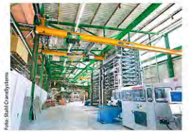
Individuell und innovativ: Der Spezialkran von STAHL CraneSystems-Partner Innokran im Einsatz.
