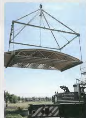
Mit dem 4-Punkt-Spreizsystem (Länge 15 m, Breite 6,50 m, Eigengewicht 6 t) konnten die einzelnen Segmente des Dachstuhls sicher abgebaut und punktgenau wieder montiert werden
