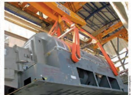
Bild 3: Schwere Fracht: Zum Heben der Generatoren werden zwei der Krane in Tandembetrieb geschaltet, die Lastaufnahme erfolgt per Spezialtraverse.
