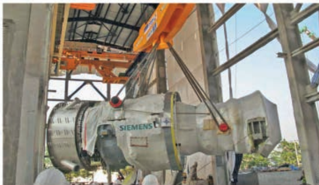
Bild 1: Über 300 t wiegen diese Turbinen von Siemens, die mithilfe der präzise steuerbaren Seilwinden von Stahl-Crane-Systemen millimetergenau platziert werden.
