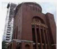
Planetarium Hamburg im Innern des Gebäudes.
