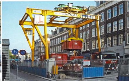
1 Test auf Herz und Nerven: Spezialseilzüge für Indien. 2 Einsatz in Amsterdam: Portalcrane auf der U-Bahn-Baustelle. 3 Stahl-Kran-Systeme bei Wolf + Heckel
