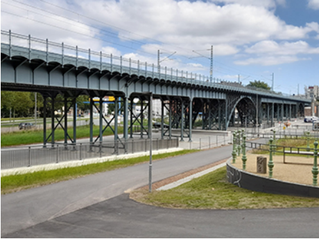
Bild 1 Chemnitzer Viadukt aus Stahl
