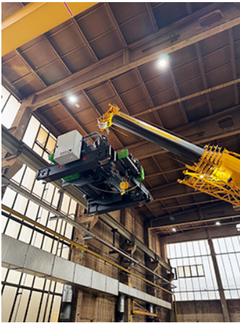
Bild 2 Hebezeugmontage
