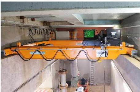
Zweiträgerbrückenkran mit Zwillingshubwerk und kontinuierlicher Lastkontrolle
