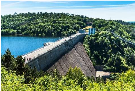
Die Rappbode-Talsperre ist ein "Historisches Wahrzeichen der Ingenieurbaukunst in Deutschland"
