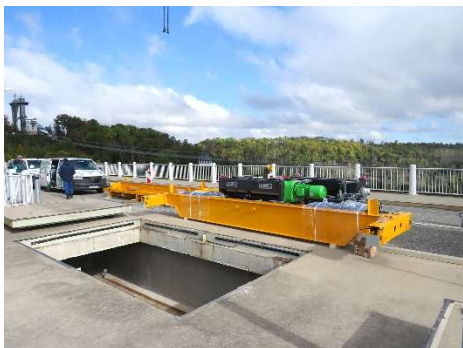
Mit einer Öffnung von nur 2 m x 4 m ist die Luke ebenso wie der Einbauraum äußerst eng
