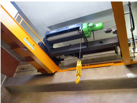
Seilzug von STAHL CraneSystems für maximale Hubhöhe von 102 m und Traglasten bis 16 t
