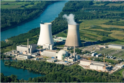
Das Kernkraftwerk Philippsburg (Bildquelle: EnBW)
