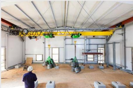
Noch gibt es hier kein explosives Gas: Der Spezialkran auf der Baustelle der Mess- und Regelstation wird bei der Abnahme mit 125 % der zulässigen Nennlast von 6,4 t getestet.
